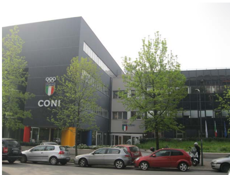
Foto 2: Ingresso pedonale al Complesso edilizio da via Piranesi
