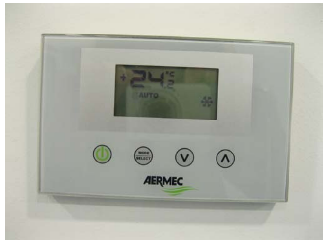
Foto 16: Edificio A – Termostato ambiente
