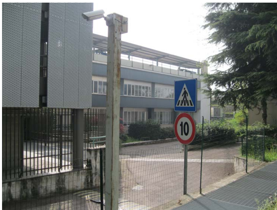
Foto 8: Edificio B – vista dall'area interna di pertinenza, lato ingresso carrabile (segnaletica stradale)
