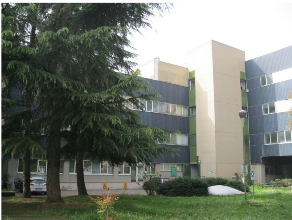
Foto 5: Edificio A – vista dall'area interna di pertinenza del Corpo a tre piani, all'innesto con uno dei corpi a due piani
