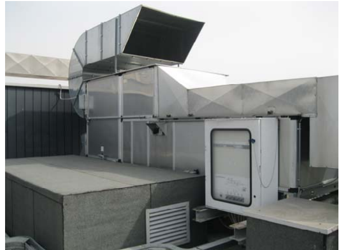
Foto 17: Edificio A – Macchina frigorifera (Chiller) Foto 18: Edificio A – UTA Unità Trattamento Aria
