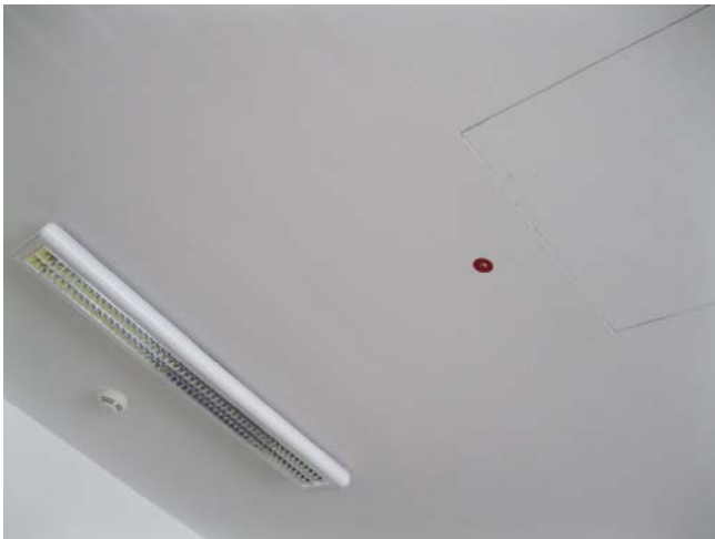
Foto 22: Edificio A – Rilevatori a plafone
