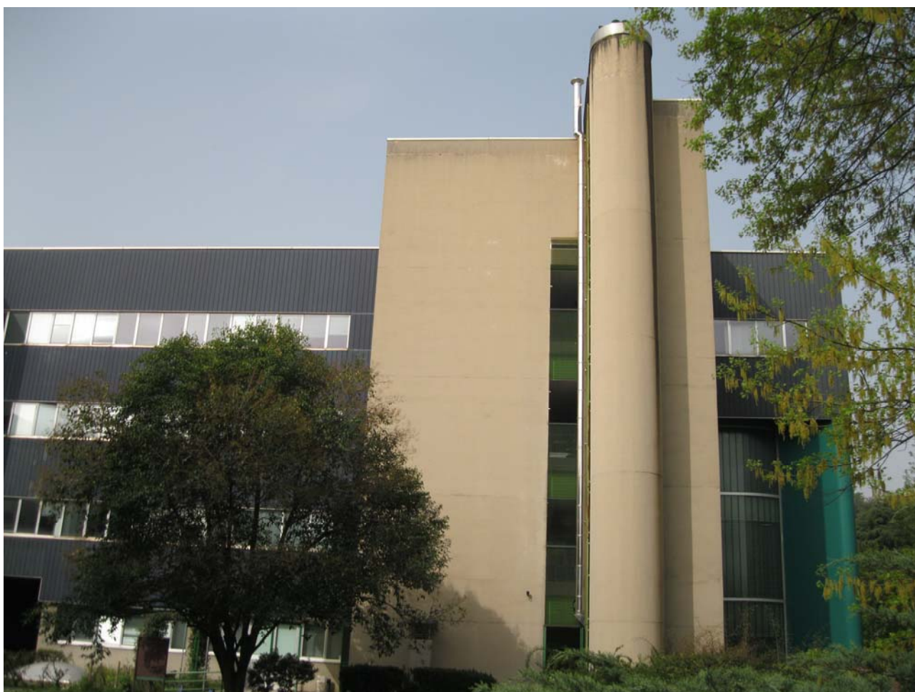
Foto 4: Edificio A – vista laterale (dall'area interna di pertinenza) del Corpo a tre piani, intestato su via Piranesi
