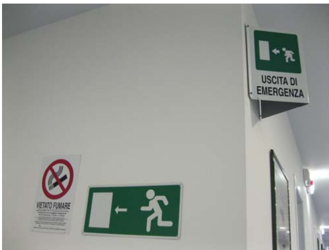
Foto 26: Edificio A – Divieto di fumo, Segnaletica
