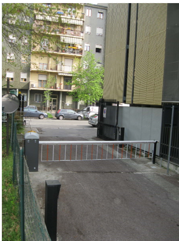
Foto 3: Ingresso carrabile da via Piranesi alla corte interna di pertinenza del Complesso edilizio
