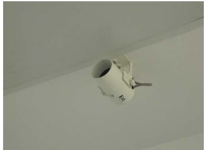
Foto 23: Edificio A – Rilevatore ad infrarosso
