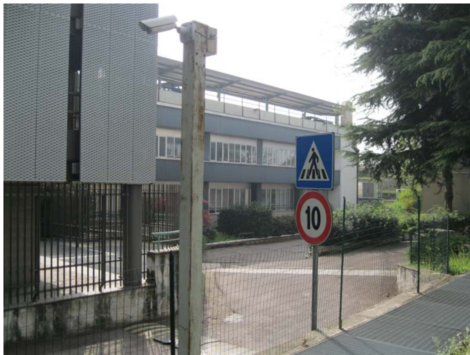
Foto 8: Edificio B – vista dall'area interna di pertinenza, lato ingresso carrabile (segnaletica stradale)
