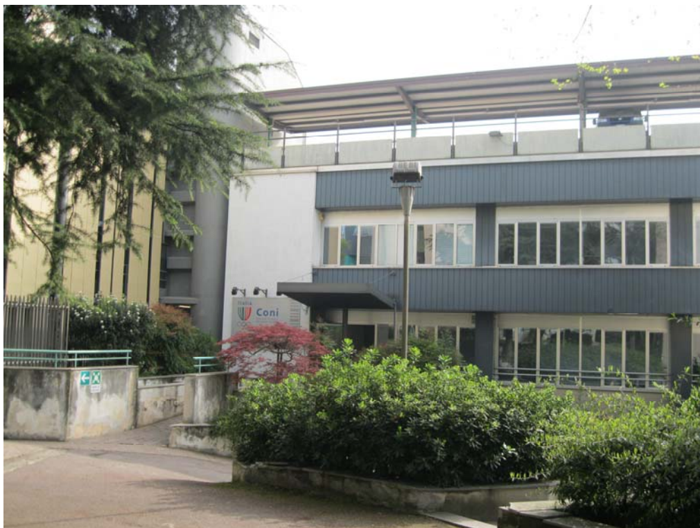
Foto 10: Edificio B – vista dall'area interna di pertinenza
