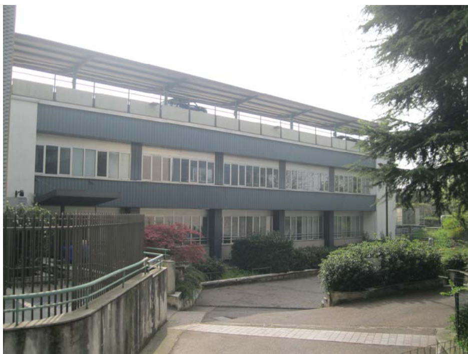
Foto 9: Edificio B – vista dall'area interna di pertinenza, lato ingresso carrabile
