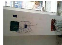
Si procede, con le modalità di aggancio dei capicorda dei conduttori al cavo pilota ed immissione nei canali sottotraccia, a stendere tutti i cavi fino a completamento di tutti i tracciati interni ed esterni degli appartamenti.
