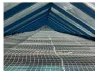
Le reti di sicurezza vengono divise in 4 sistemi denominati S, T, U, V, che differiscono fra loro per l'intelaiatura di sostegno dei bordi e per l'uso orizzontale o verticale. Essi sono diversi per la forma che assumono una volta installati e per la tecnica di messa in opera.
