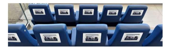
Le dimensioni dello scasso per il monitor all'interno delle poltrone esistenti dovranno essere compatibili alla dimensione del Tablet o alla dimensione della Teca che proteggerà il Tablet da agenti esterni
